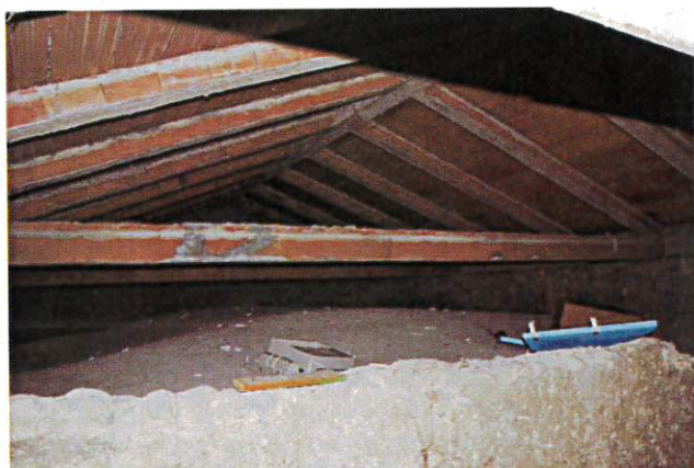
Figura 24 Sottotetto della chiesa di S. Maria Argentea a Norcia, con solai in laterocemento (Foto P. Berti, Mibact).
